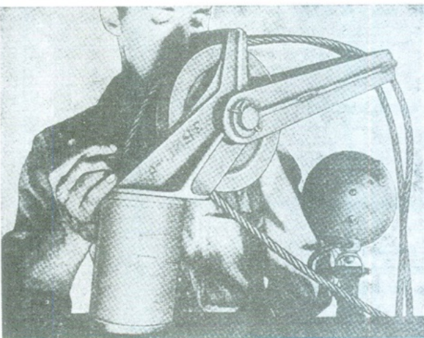
Fig. 190. — Uiteenname van de katrol van het chassis.
